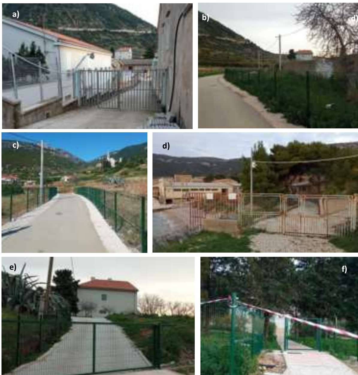
Slika 17. Ograde zemljišta nekadašnje tvornice Neptun, a) sjeverni ulaz, stanje 10.01.2025., b) ograde uz obilaznu cestu, stanje 10.01.2025. c) ograde uz obilaznu cestu, stanje 17.06.2024., d) južni ulaz, stanje 10.01.2025, e) i f) ulazi u radnički dom, stanje 10.01.2025.
