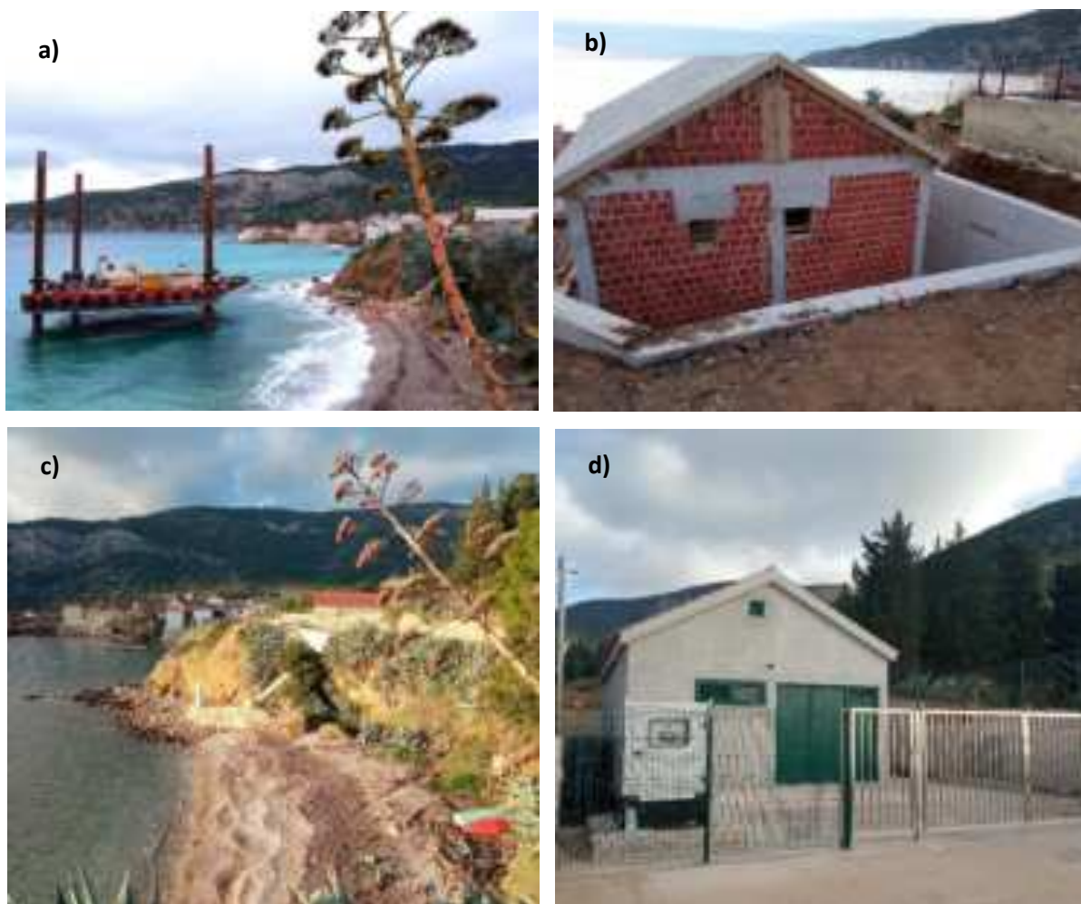
Slika 13. Radovi na izgradnji kanalizacijske infrastrukture: a) polaganje podmorskog ispusta, stanje 04.12.2021., b) objekt sustava za pročišćavanje otpadnih voda, stanje 04.12.2021., c) plaža za pse, stanje 20.12.2022., d) objekt sustava za pročišćavanje otpadnih voda, stanje 20.12.2022.
