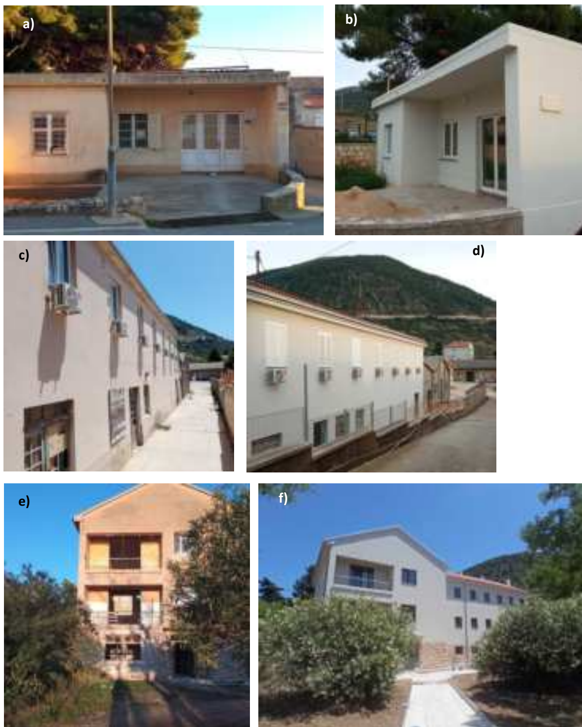
Slika 16. Objekti nekadašnje tvornice za preradu ribe Neptun: a) porta, stanje 14.02.2024., b) porta, stanje, 10.01.2025., c) upravna zgrada, stanje 16.06.2024., d) upravna zgrada, stanje 10.01.2025., e) Radnički dom, stanje 14.02.2024., f) Radnički dom, stanje 16.06.2024.
