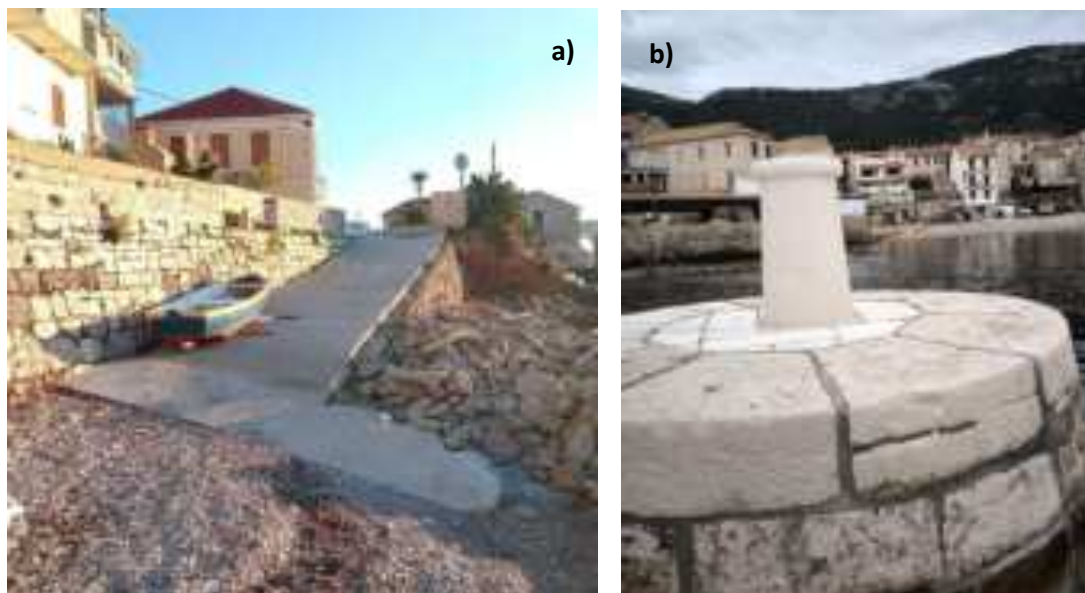
Slika 15. Plaže Jurkovicica, Žanićevo i Kalafotovo: a) izgrađena rampa sa betonskom podlogom na plaži Jurkovicica, stanje: 14.02.2024., b) obnova kamenih koluni u moru uz plaže Žanićevo i Kalafotovo, stanje 21.01.2025.
