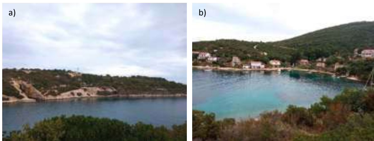
Slika 14. Lokacija izgradnje marine Parja-Rogačić, stanje 26.12.2021.: a) uvala Parja i b) uvala Rogačić.
