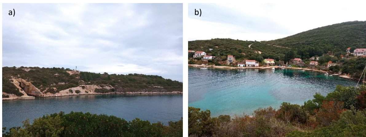
Slika 9. Lokacija izgradnje marine Parja-Rogačić, stanje 26.12.2021.: a) uvala Parja i b) uvala Rogačić.
