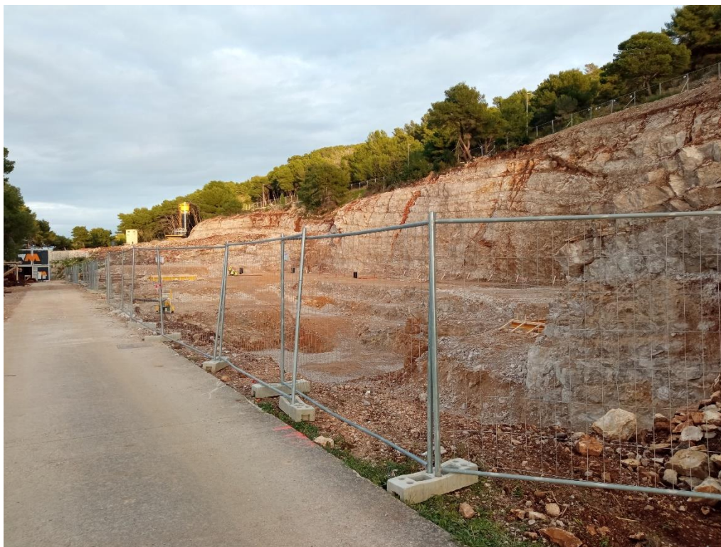
Slika 8. Provedeni građevinski radovi iskopa u sklopu prostorne cjeline 2 zone Češka vila, stanje 24.12.2021.
